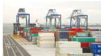
管理棟からY1ターミナル岸壁側を望む
