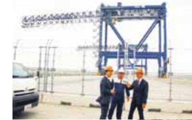
Y2に設置されたシャトル式ガントリークレーン
